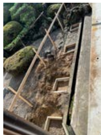
久遠靈堂の基礎工事
