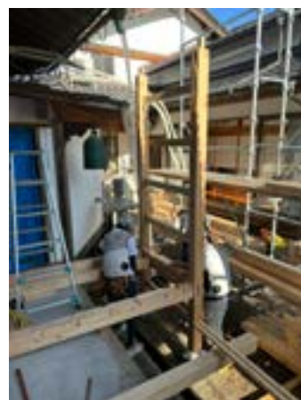
9月12日に久遠霊堂の建前工事 意外と大きな建物です 本堂の大屋根の下の屋根取り付け工事は狭く手間がかかりました
