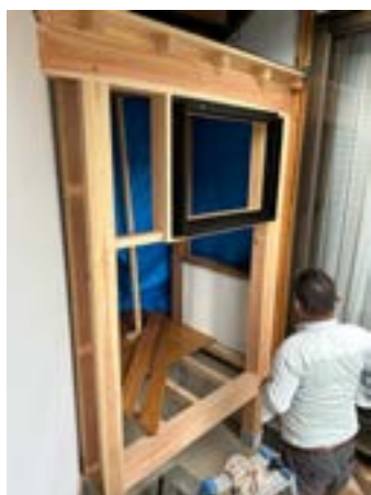
水屋工事のようす
