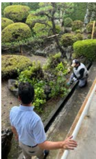
工事前の庭園の景観
