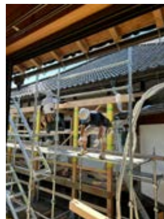
柱が立ち桁 けた の取り付けです
