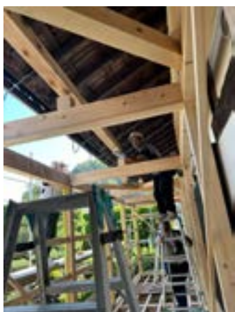
9月12日に久遠霊堂の建前工事 意外と大きな建物です 本堂の大屋根の下の屋根取り付け工事は狭く手間がかかりました
