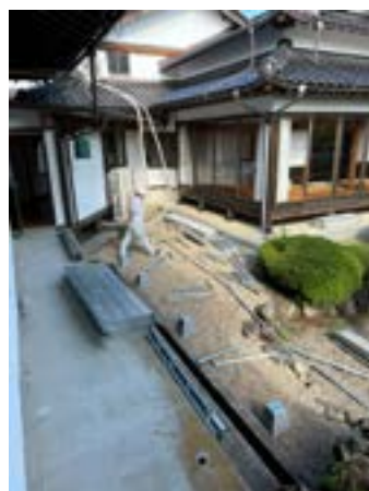
本堂から庫裏 基礎工事
