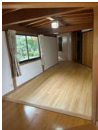
傾斜を付けて段差解消しました
