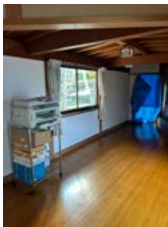
工事前の本堂と庫裏の廊下
