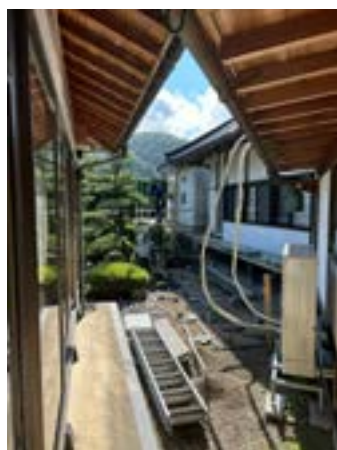
足場の工事が始まりました
