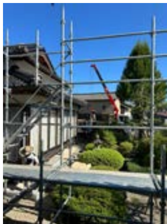
建物の材料が搬入されました
