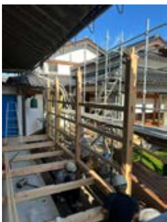
9月12日に久遠霊堂の建前工事 意外と大きな建物です 本堂の大屋根の下の屋根取り付け工事は狭く手間がかかりました
