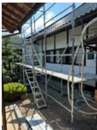
足場が設置されました
